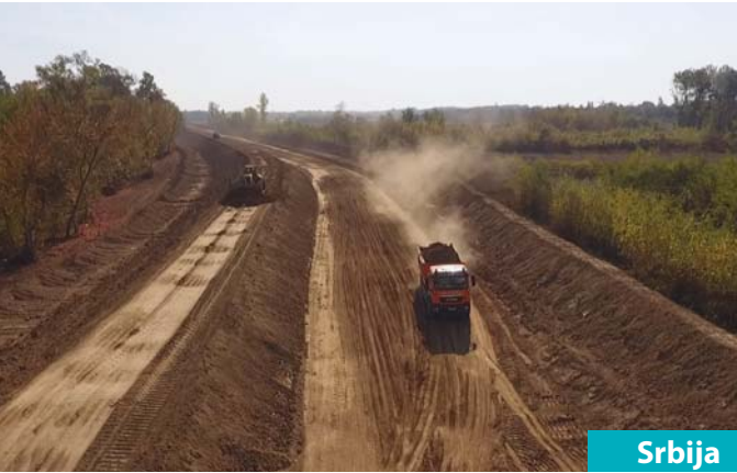
Srbija Projekat Usluga Investitor Rekonstrukcija sistema zaštite od poplava Mačva Nadzor nad izgradnjom Delegacija Evropske Unije u Republici Srbiji
