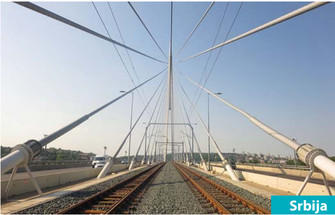
Srbija Projekat Usluga Investitor Izvođenje tramvajske pruge na mostu na Adi Izvođenje radova; Gradska uprava grada Beograda
