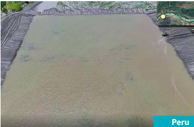
Peru Projekat Usluga Investitor Preventivno čišćenje reke Čire Izvođenje radova na dve deonice (od km 25 do km 40 i od km 52+900 do km 53+670); MINAGRI Ministerio de Agricultura y Riego
