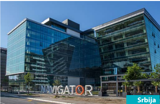
Projekat : Poslovni objekat Navigator Business Center 2 Usluga : Izvođenje radova Investitor : GP SEVEN d.o.o. Beograd
