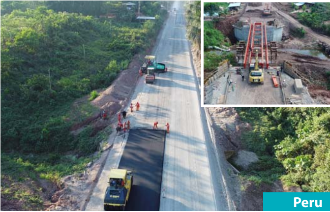
Peru Projekat Usluga Investitor Rehabilitacija i rekonstrukcija deonice puta Puerto Bermudes - Ciudad Constitucion Poboljšanje, proširenje i asfaltiranje deonice puta, rehabilitacija postojećih i izgradnji tri nova mosta; Provias Nacional del Ministerio de Transporte y Comunicaciones
