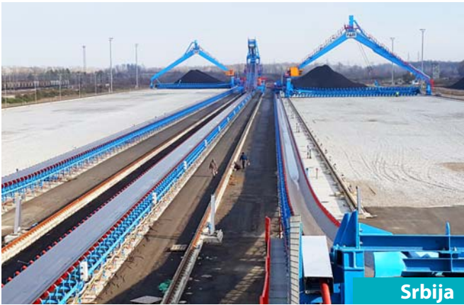
Srbija Projekat RB Kolubara, Projekat C, paket 2: Infrastruktura za sistem upravljanja kvalitetom uglja Usluga Isporuka opreme i materijala, izvođenje građevinskih, mašinskih i elektro radova, primopredaja, puštanje u rad; Investitor JP Elektroprivreda Srbije (EPS)
