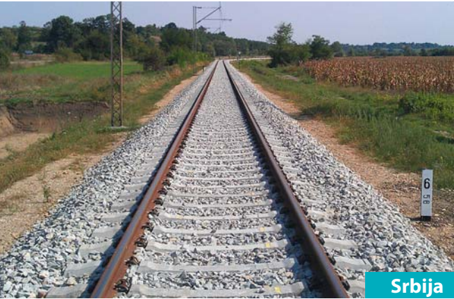
Srbija Projekat Deonica pruge - Jajinci - Mala Krsna - Velika Plana i železnička stanica "Mala Krsna" Usluga Izvođenje građevinskih i elektroradova; Investitor Infrastrukture železnice Srbije, Beograd
